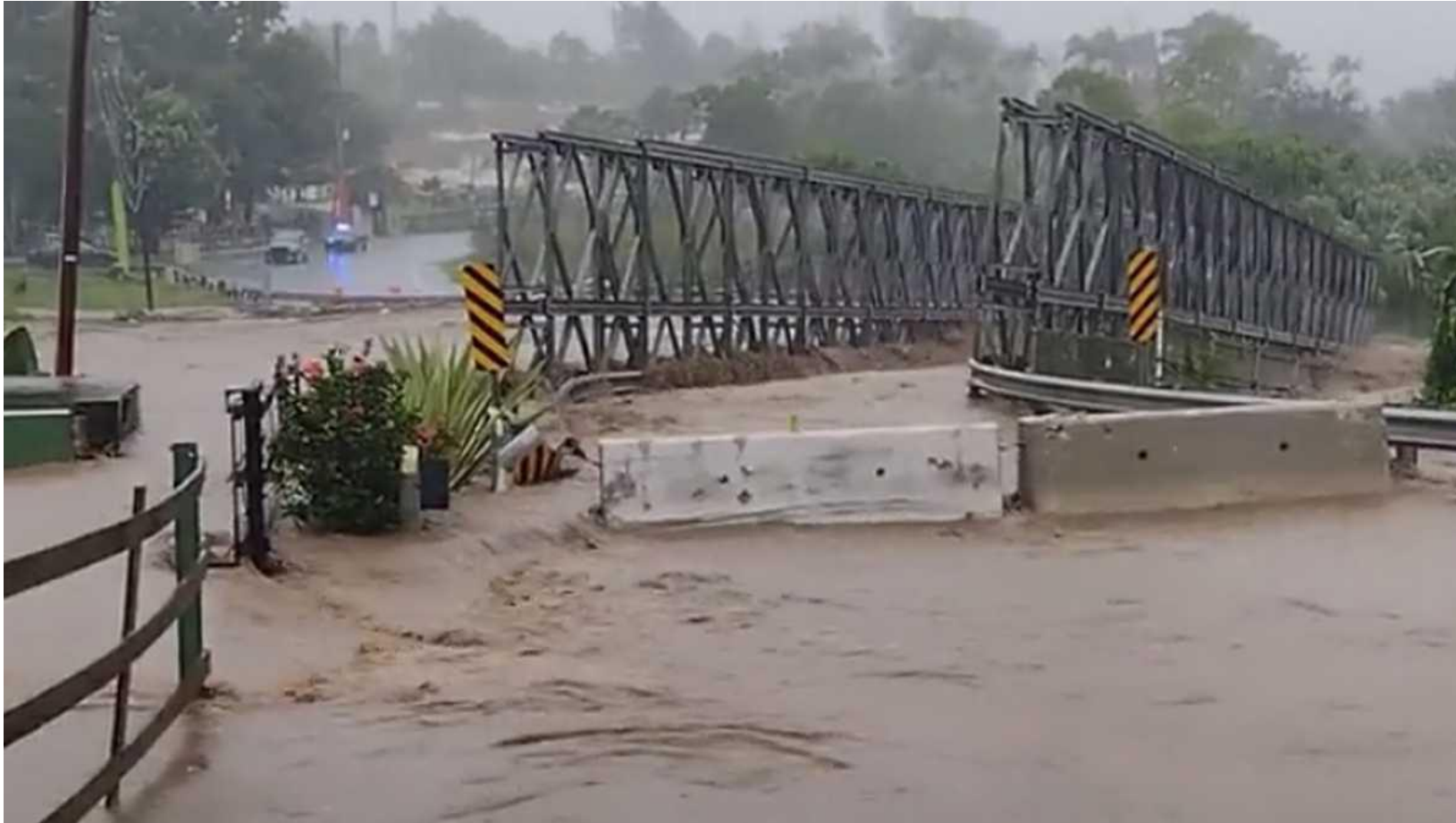
Puente provisional colapsado, Huracán Fiona, instalado post Huracán María
